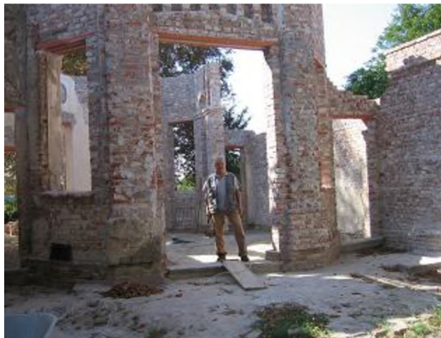
Vukovar, obnova kapelice na groblju
