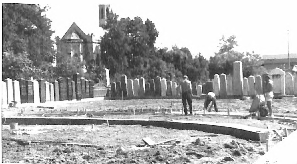
Postavljanje betonskih temelja na novoj lokaciji Jevrejskog groblja. U pozadini se vide već postavljene nadgrobne spomenice, kao i kapela evangeličko-reformatskog groblja (Foto: A. Greber, ljubaznošću Jevrejske opštine Zrenjanin)
