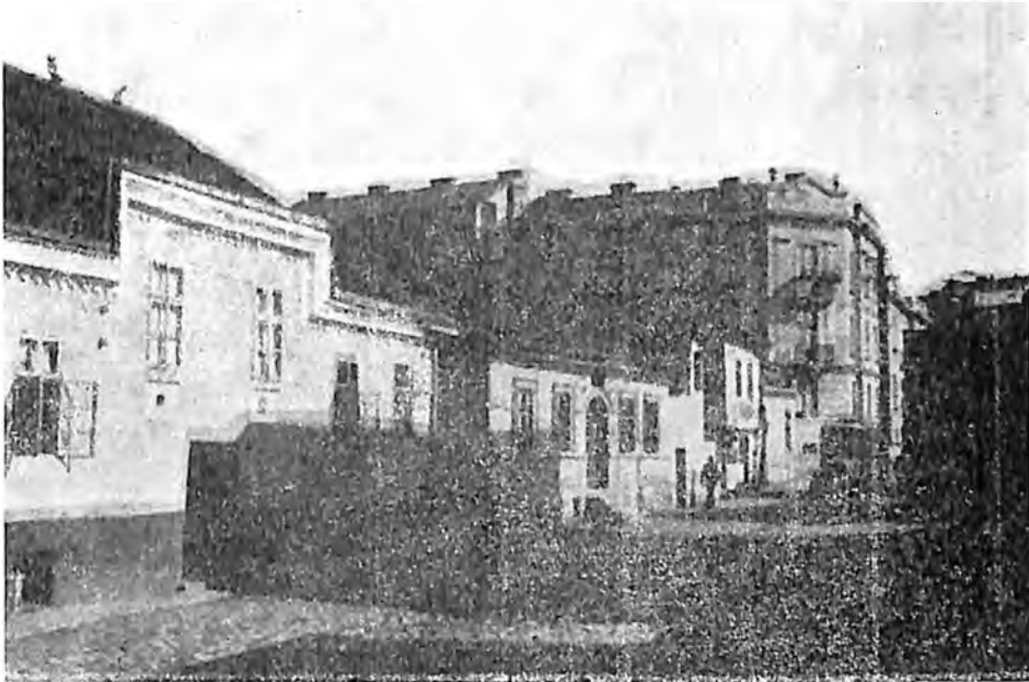
Sl. 10 — Deo parne strane Jevrejske ulice oko 1930 g. Sasvim levo je zgrada br. 14, a dalje su ostale zgrade do br. 4 (Foto Jeremija Stanojević, MGB. Ur. 6375)
