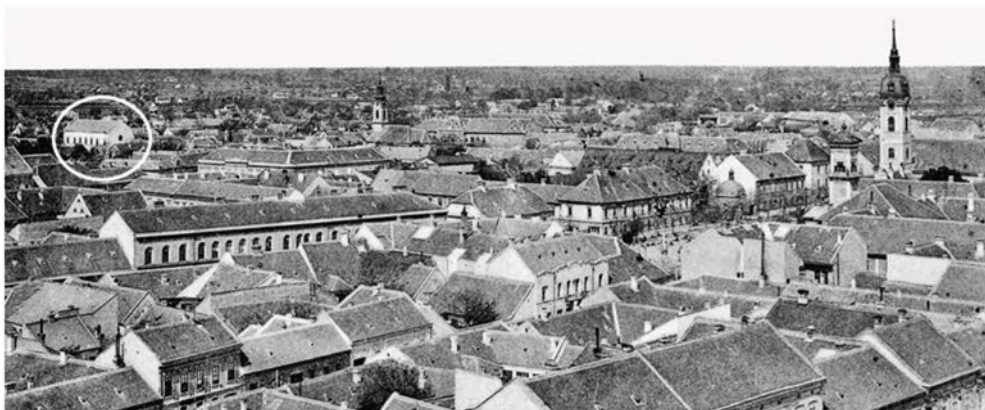
Zgrada sinagoge (zaokružena) na panorami Sombora iz 1909. g.
