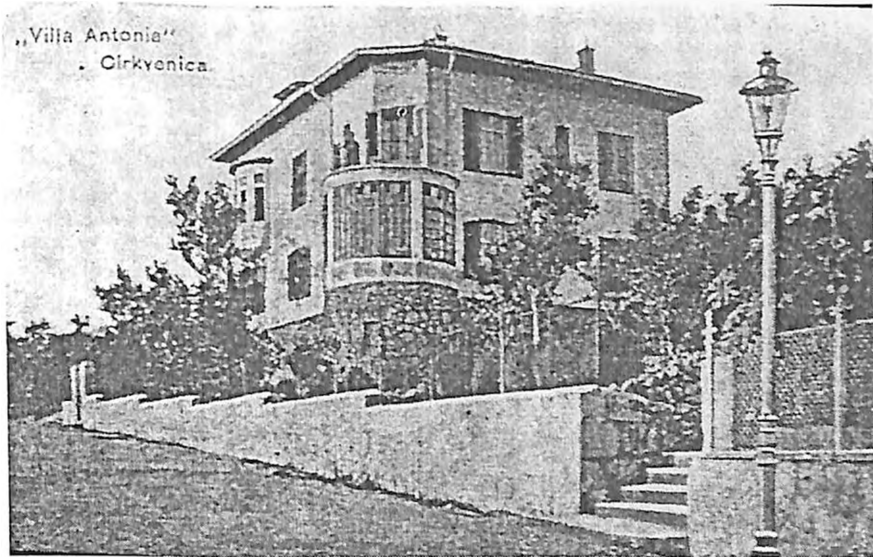
Sl.26. Ferijalni dom u Crikvenici, osnovan 1923. iz sredstava Zaklade Tilde Deutsch Maceljske za osnutak ferijalnih domova Youth Holiday Home at Crikvenica, constructed in 1923 owing to the funds of the Tilda Deutsch Maceljski foundation for founding youth holiday homes
