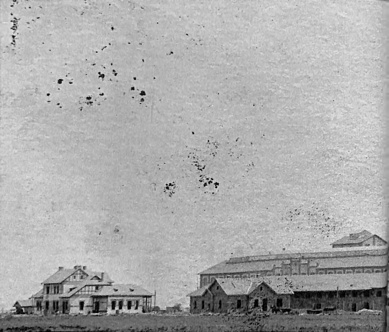
Izgradnja kompleksa šećerane, 1911_Construction of the Sugar factory complex, 1911_Ferenc Nemet
