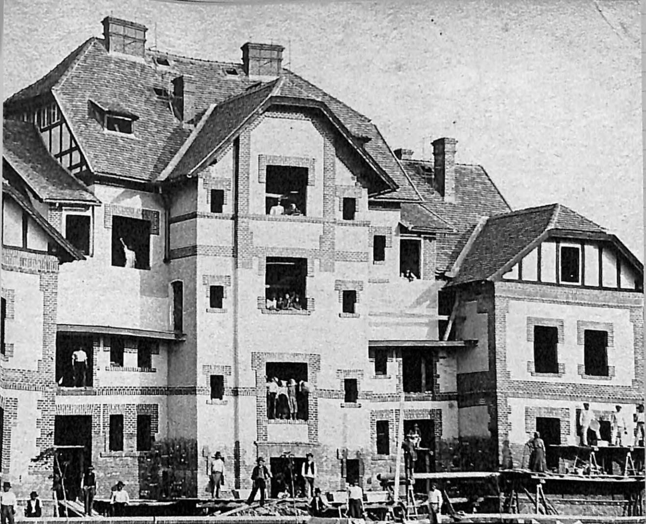
Izgradnja kompleksa šećerane, 1911_Construction of the Sugar factory complex, 1911_Ferenc Nemet
