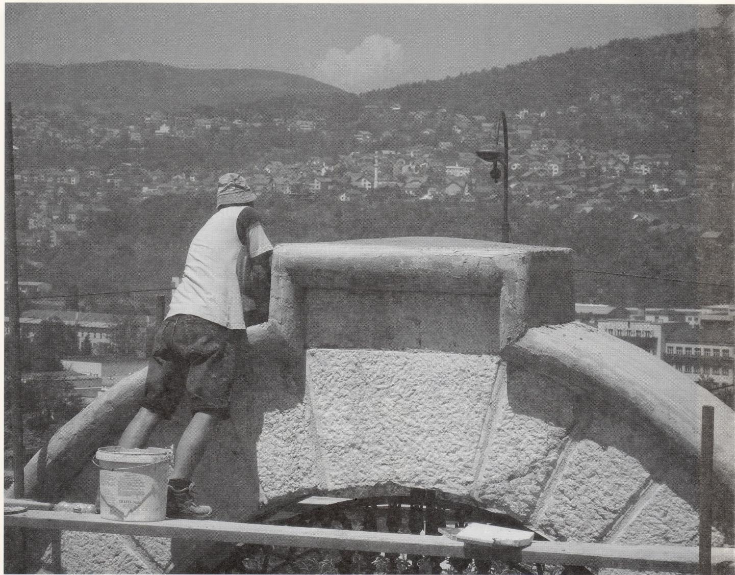
Tokom rekonstrukcije armirano-betonske pokrivne kape Kapije, uz obavljene konsultacije sa stručnim konsultantima firme Röfix iz Hrvatske, kao završna obloga armiranobetonke pokrivne kape, u cilju obezbjeđivanja njene pojačane vodonepropusnosti, visoke paropropusnosti i visoke otpornosti na djelovanje štetnih soli, upotrebljena je prvo mješavina Žbuke za saniranje R-W Röfix 640 i Bijele žbuke za saniranje Röfix 650, a zatim je nanesen završni sloj od hidraulične vapnene fine žbuke Röfix 380.
