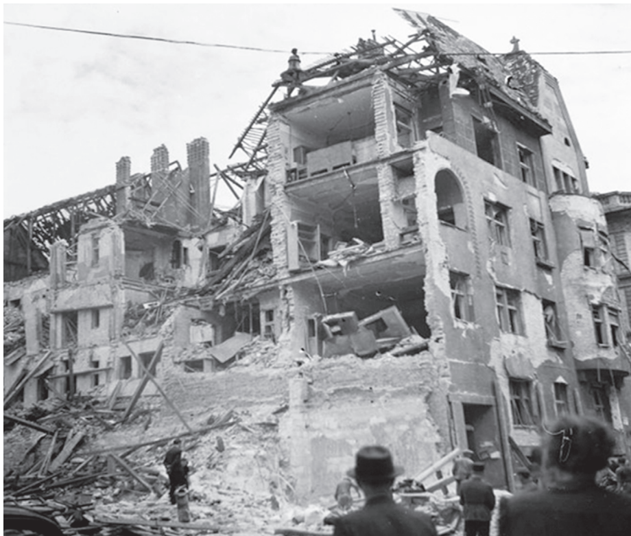
Bombardiranjem srušena zgrada, József utca (izvor: fortetpan.hu)
