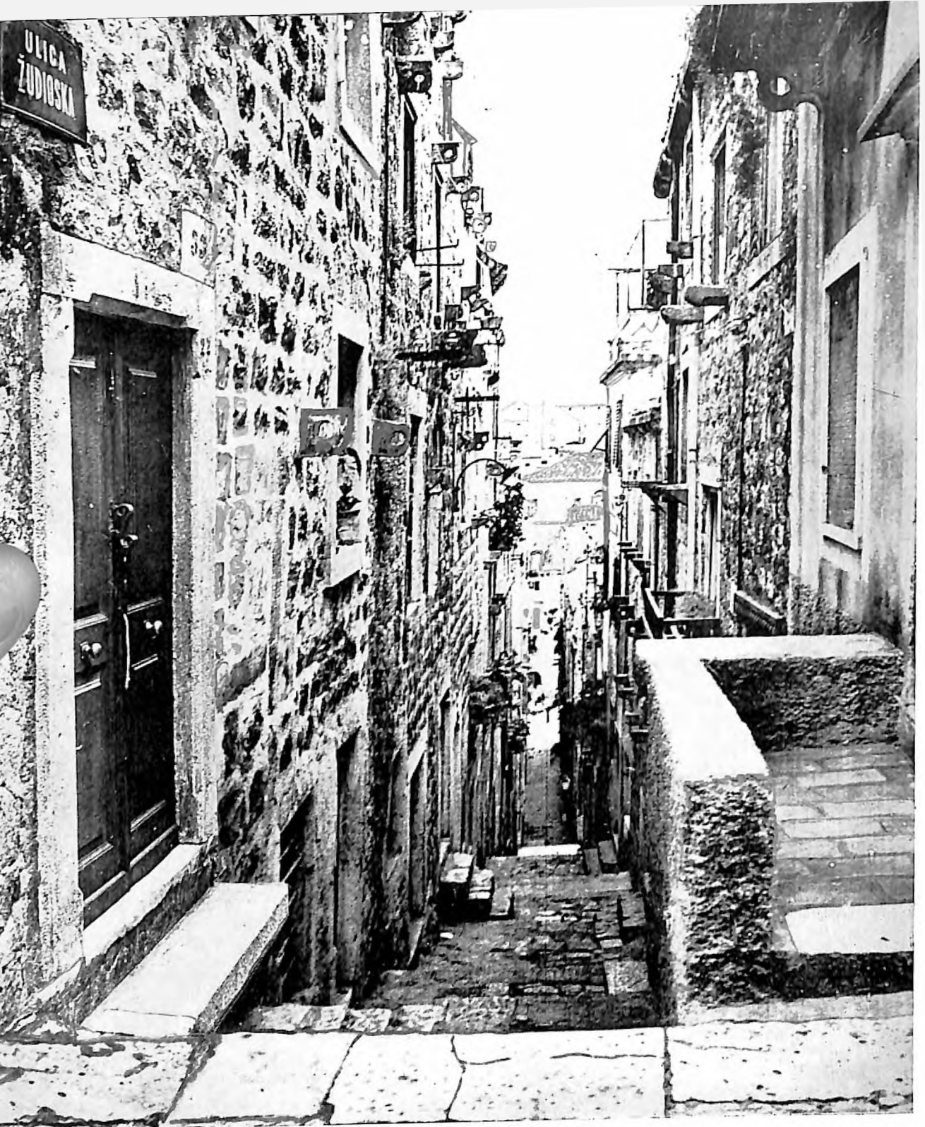
Žudioska ulica snimljena sa Pelina (snimio Z. Etron).
