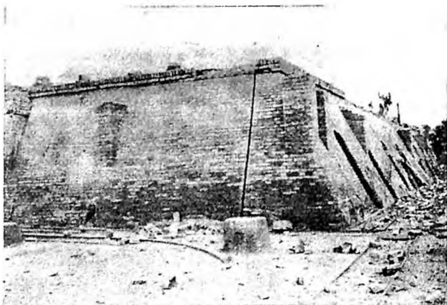
Sl. 55 — Kružna peć u Jasenovcu koja je upotrebljavana i za spaljivanje zatočenika
