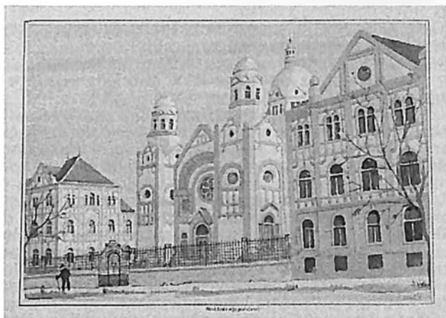
Sinagoga u Novom Sadu
