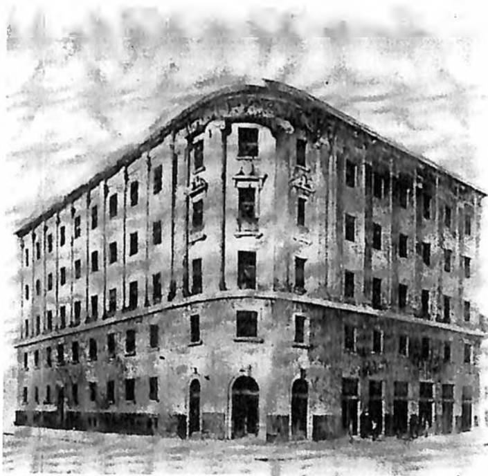
Slika 117. Zgrada na uglu Petrinjske i Amruševe ulice koju je Židovska općina sagradila 1927. godine. Jewish Building (1927) on the corner of Petrinjska and Amruševa street in Zagreb
