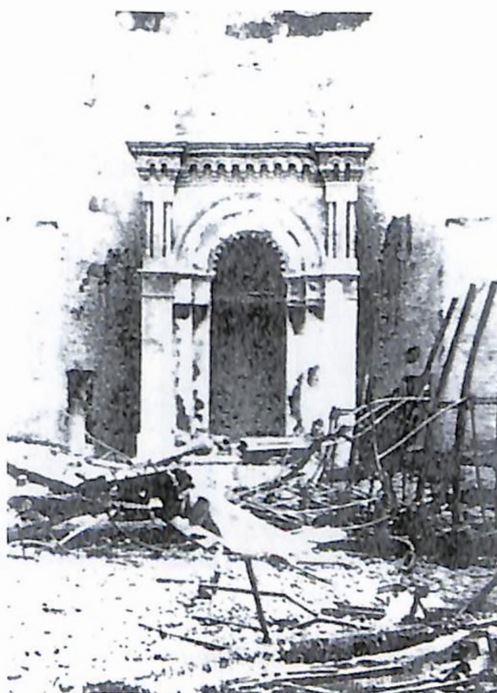
Sl. 17. Sinagoga u Osijeku poslije rušenja
