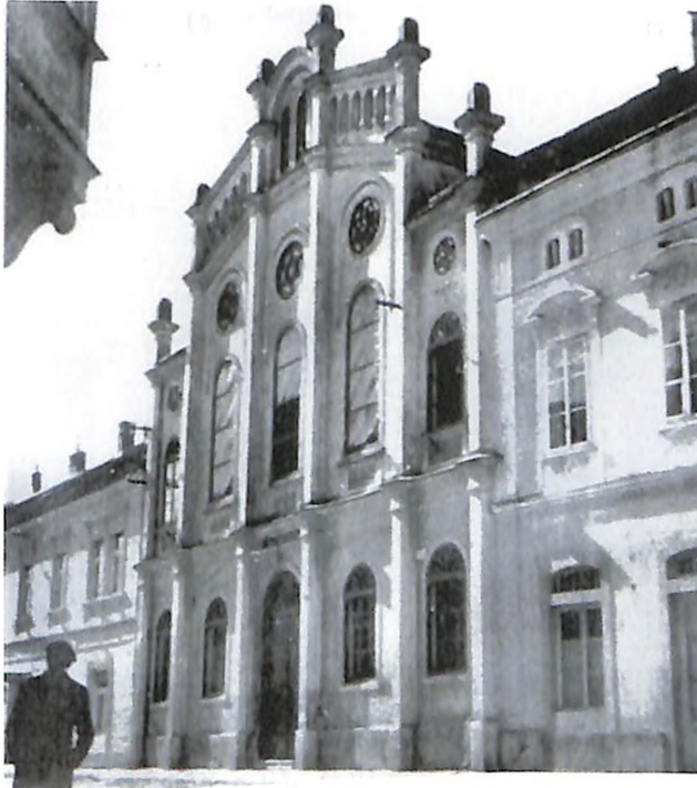
Sl. 29. Sinagoga u Karlovcu
