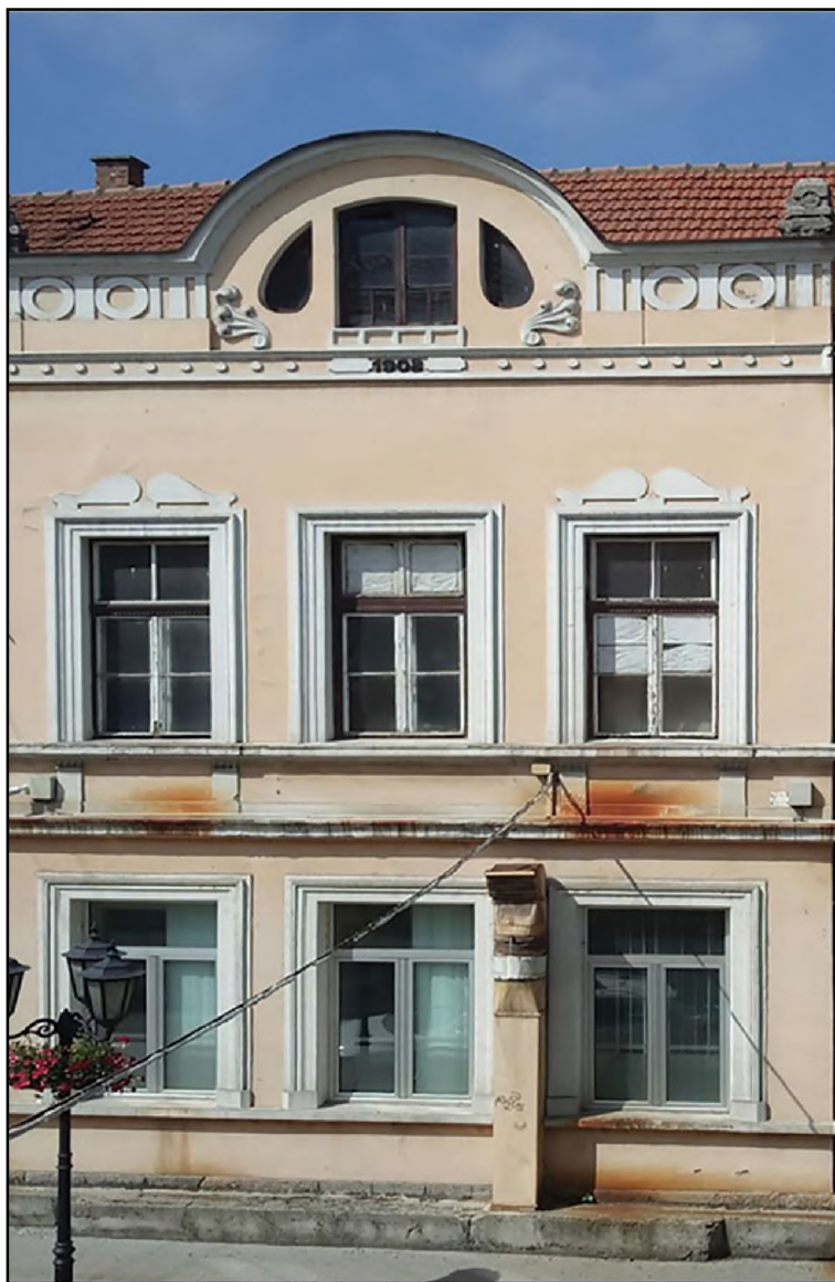
Sl. 6. Detalj fasade s objekta Leopolda Šajberana na kojoj se vidi godina izgradnje (Fototeka Zavičajnog muzeja – Visoko)
